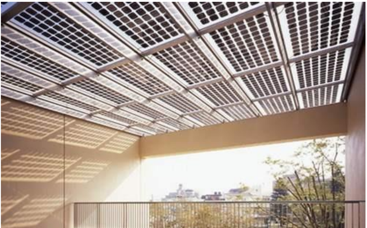
esempio di copertura con pannelli FV trasparenti
