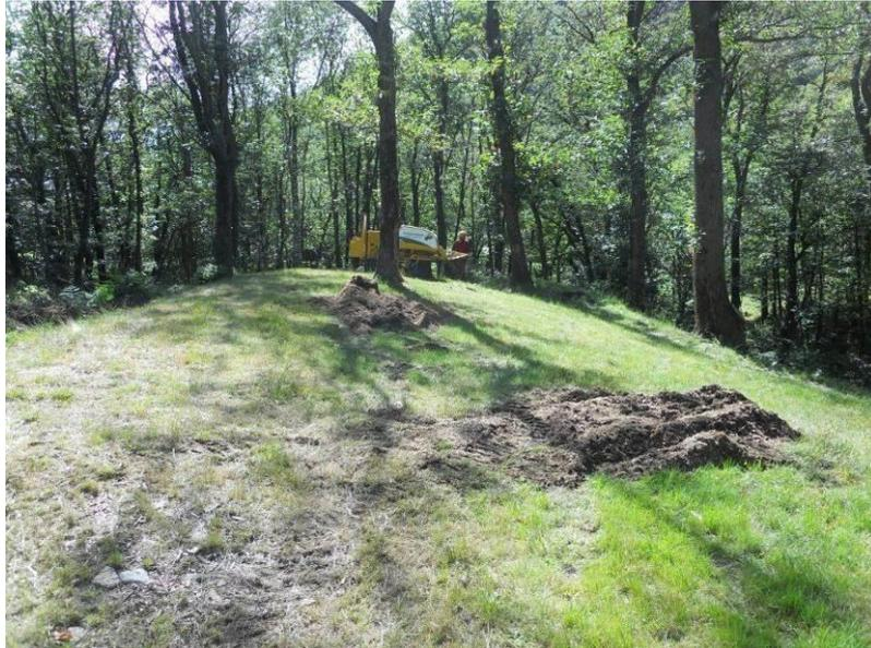
**Foto n° 2: Fresatura delle ceppaie per facilitare lo sfalcio meccanizzato**
